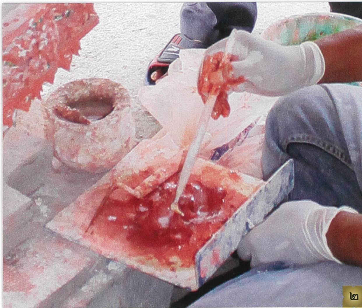
๑-๒. การผสมปูนกับกาว ไฮเซ็มเฟล็กซ์ให้เข้ากัน
